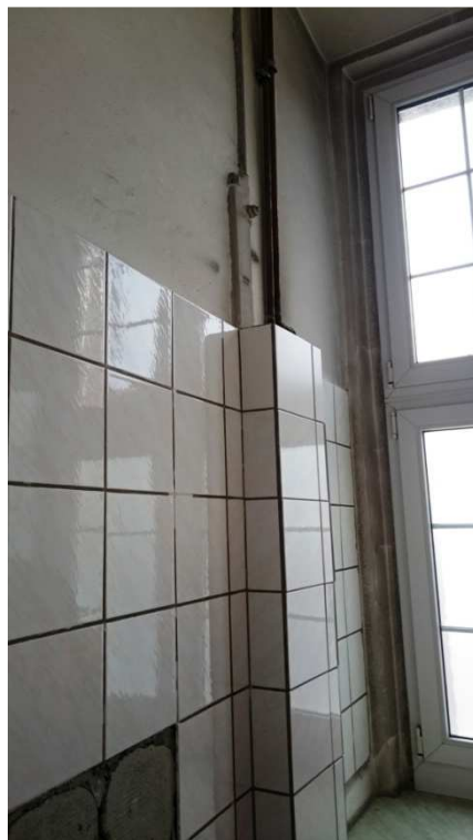
ZDJĘCIE NR 1.6. TOALETA NA I PIETRZE WIDOCZNE PIONY CO I WODOCIAGOWE DO SCHOWANIA W BRUZZACH ŚCIENNYCH
