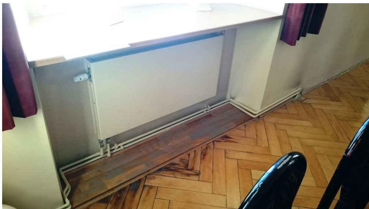
ZDJĘCIE NR 2.6. SALA NARAD – WNĘKA PODOKIENNA PRZEZNACZONA DO OBNIŻENIA, GRZEJNIKI ORAZ PARAPET DO WYMIANY, ISNATALCJA C.O. DO SCHOWANIA W BRUZZADCH ŚCIENNYCH
