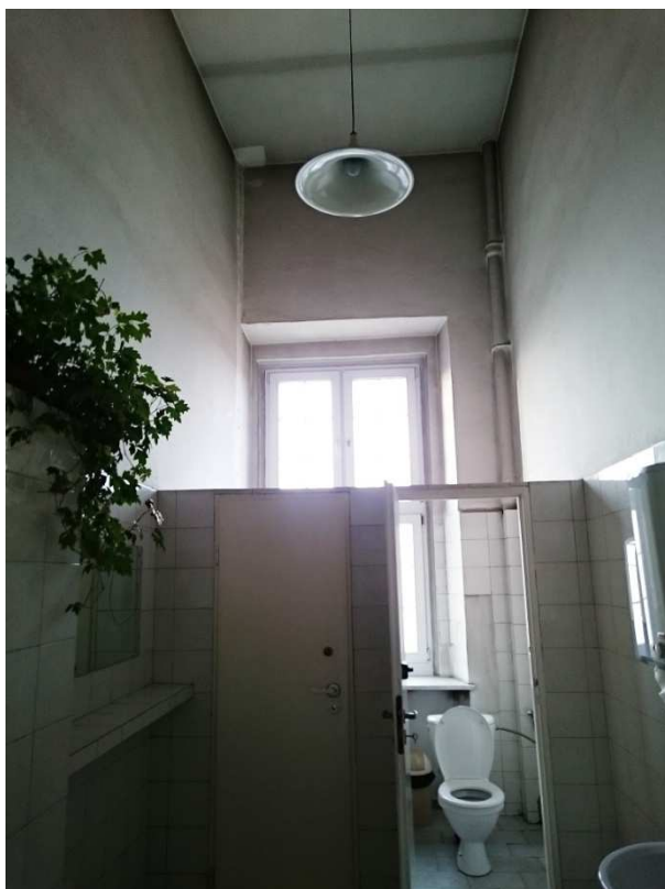
ZDJĘCIE NR 2.8. TOALETA NA II PIETRZE (Z LEWEJ STRONY WIDOCZNA ŚCIANA DO ZABUDOWY, NA WPROST – ŚCIANKI ODDZIELAJĄCE KABINY USTĘPOWE DO WYMIANY)
