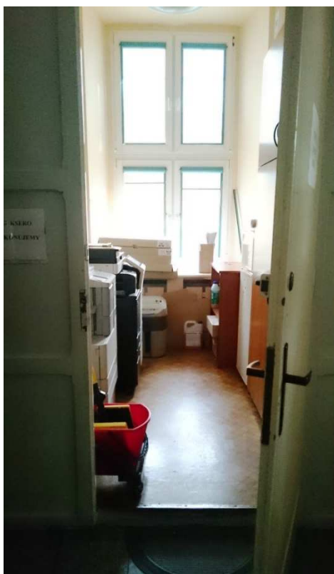
ZDJĘCIE NR 1.4. POMIESZCZENIE NR 107 – POSADZKA DO SKUCIA I WYRÓWNANIA (JAK NA KORYTARZU)
